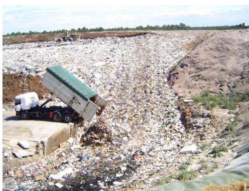
Exploitation d'une alvéole – ISDND d'Audenge (33)
